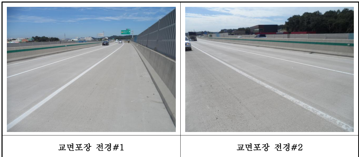
【사진 31.3.19】 교면포장 전경
