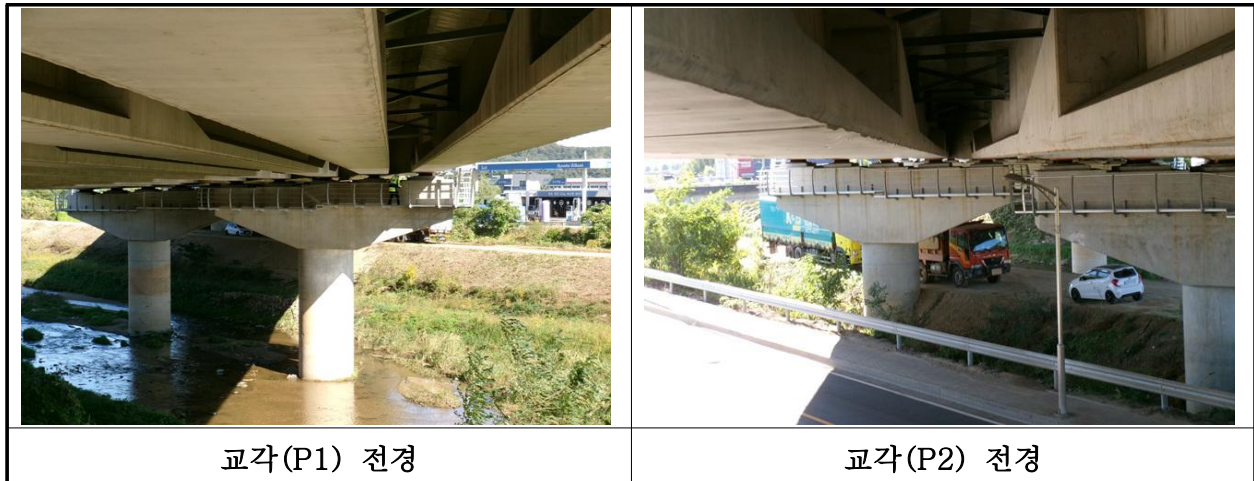
【사진 32.3.10】 교각 전경
