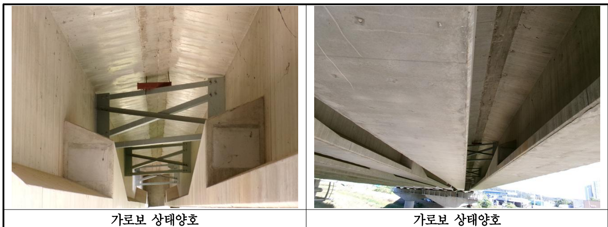
【사진 32.3.7】 가로보 손상현황
