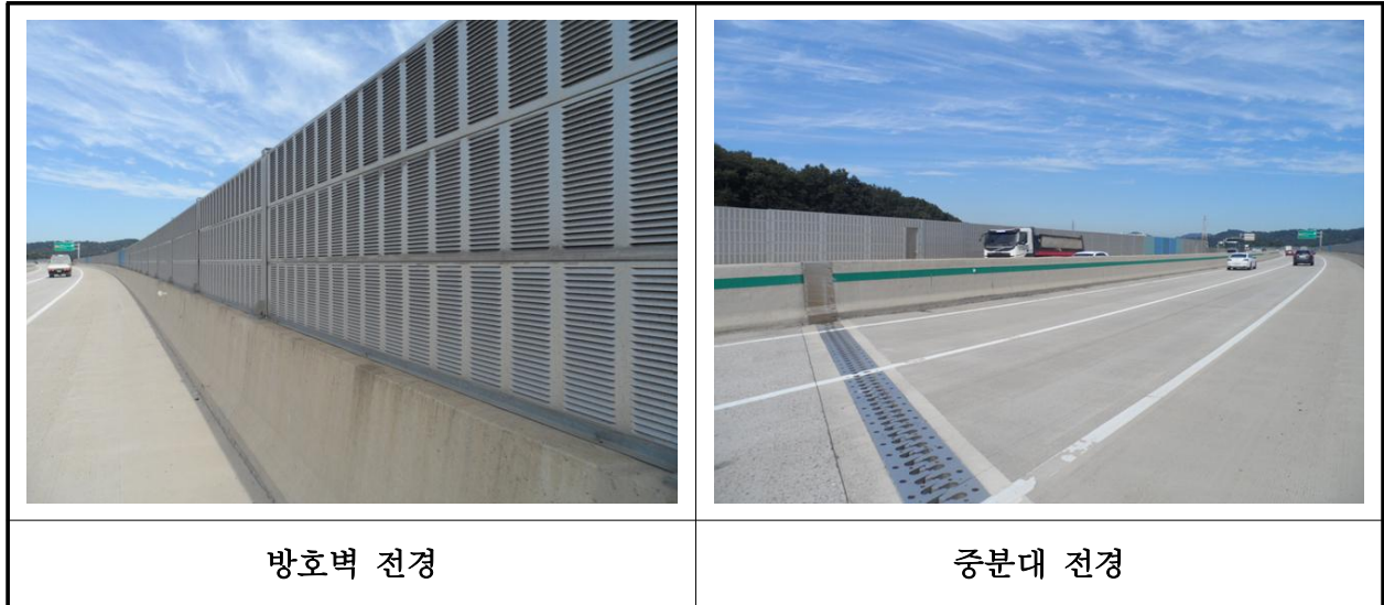
【사진 31.3.23】 방호벽 및 중앙분리대 전경
