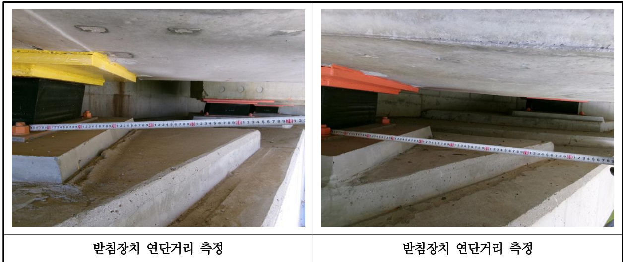
【사진 32.3.14】 교량반침장치 연단거리측정
