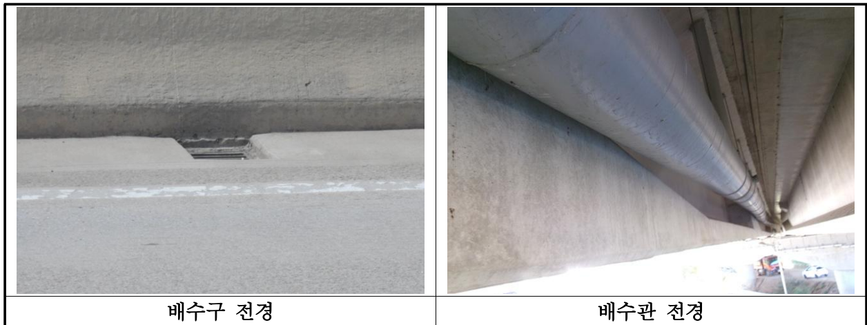
【사진 31.3.21】 배수시설 전경
