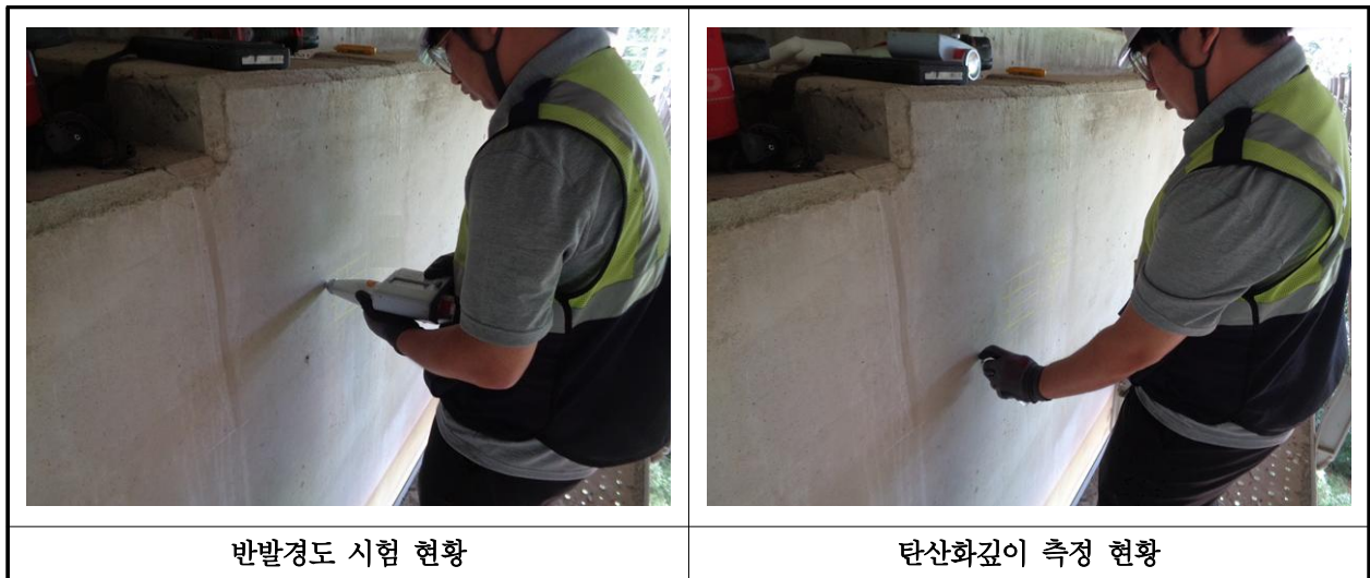
【사진 32.4.1】 콘크리트 내구성조사 현황
