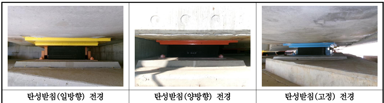
【사진 32.3.12】 교량받침 전경
