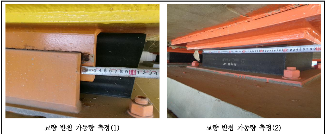
【사진 31.3.15】 교량받침 이동량 측정
