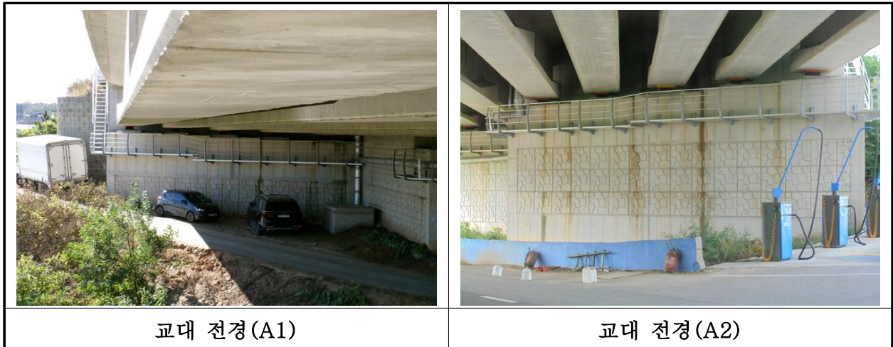
【사진 32.3.8】 교대 전경
