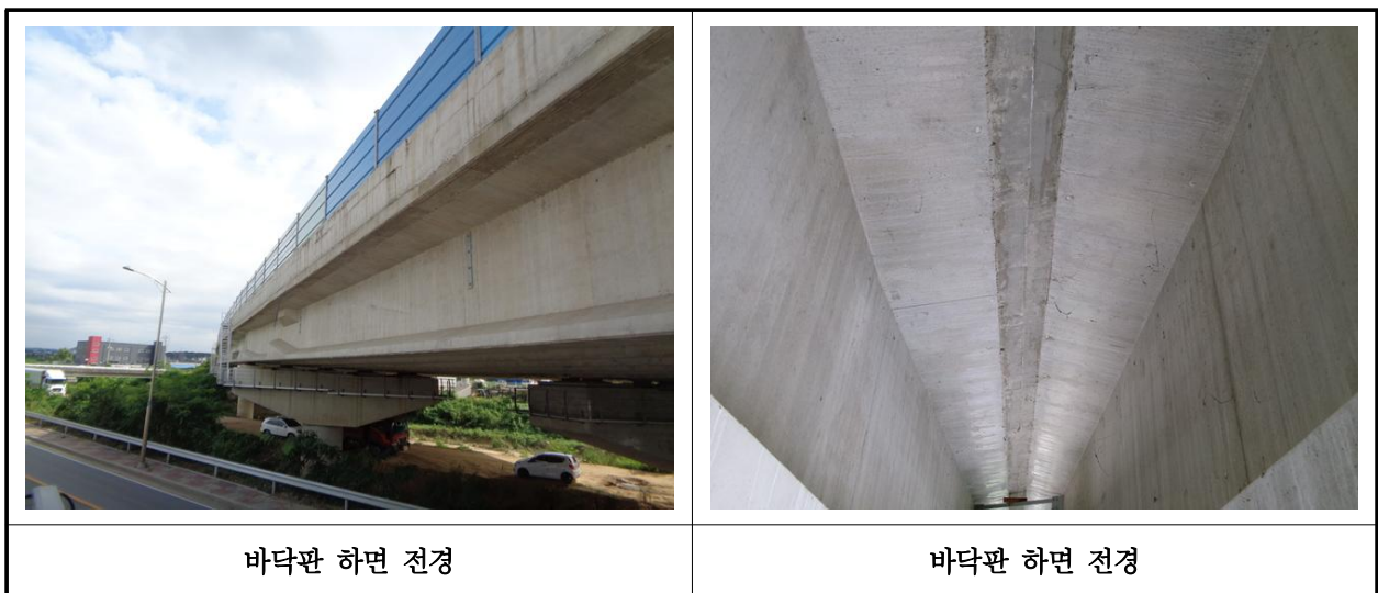
【사진 32.3.2】 바닥판하면 전경
