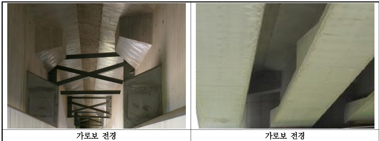
【사진 32.3.6】 가로보 전경
